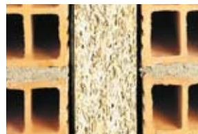
La separación entre paredes debe ser ligeramente superior al espesor del panel, para que éste pueda vibrar.
